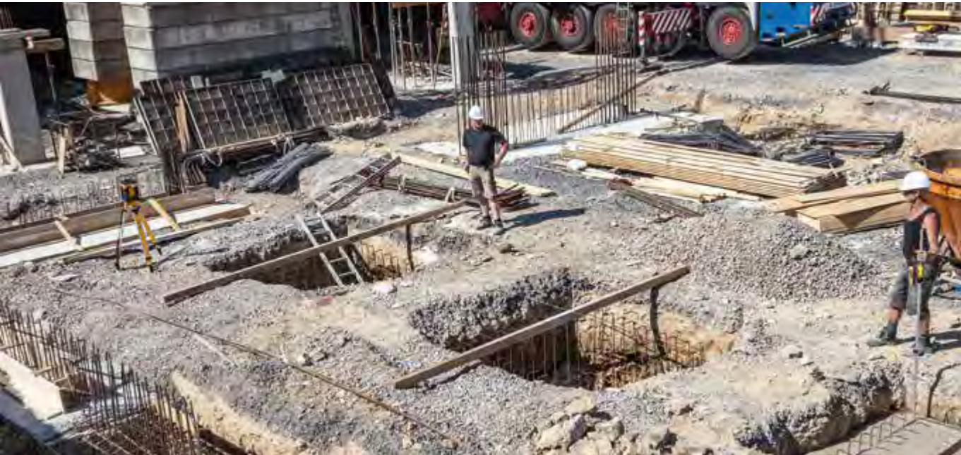
Der Laser überzeugt durch seine einfache Bedienung und steht in Kombination mit dem Receiver REC 300 Digital für schnelles und zuverlässiges Arbeiten in einem Arbeitsbereich von bis zu 800 m.
